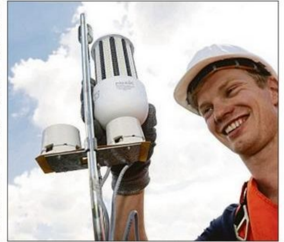
Die LEW Verteilnetz rüstet in Ruderatshofen Straßenleuchten mit energieeffizienter LED-Technik aus. Foto: LEW/Christina Bleier
